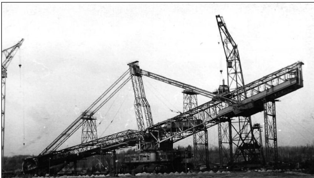
Der SRs 1500 kurz auf dem Montageplatz bei Sauo Mitte der 1960er Jahre. Foto: Traditionsverein Braunkohle Senftenberg.
