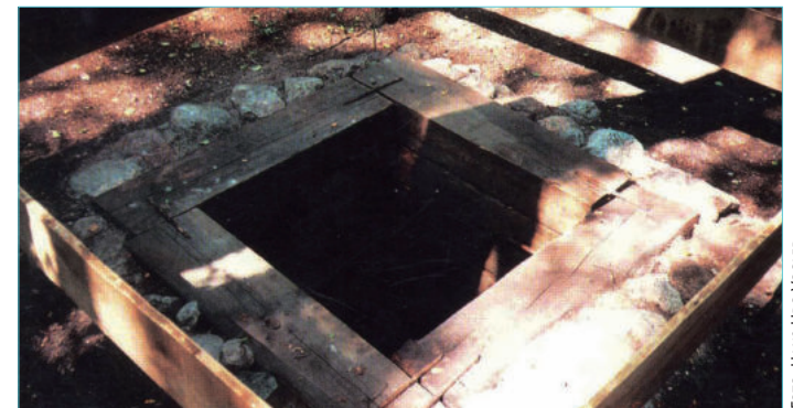
Brunnen Nossedil nach der Restauration 2002
